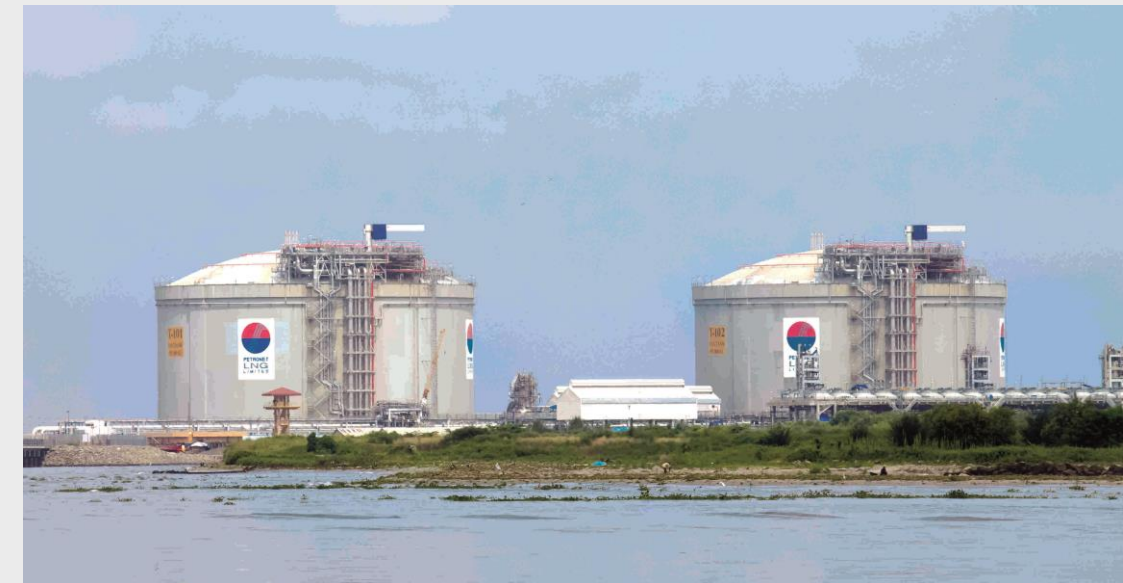
Loading of LNG tanker inside terminal
